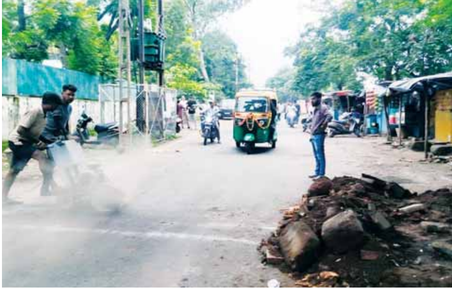
भोपाल। दोपहर मेट्रो भोपाल। शहर के प्रोफेसर कॉलोनी क्षेत्र में अमृत-2 योजना के तहत पानी की पाइपलाइन बिछाई जा रही है। लाइन डालने के लिए सड़कों की लगातार खुदाई की जा रही है। बारिश में पहले से ही सड़कों की हालत खराब है।
